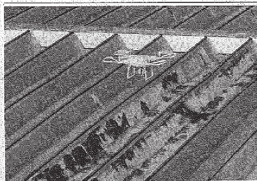
錆びた鋼板屋根をドローンで調査・診断中
