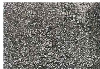
著しく劣化が見られるアスファルト面
