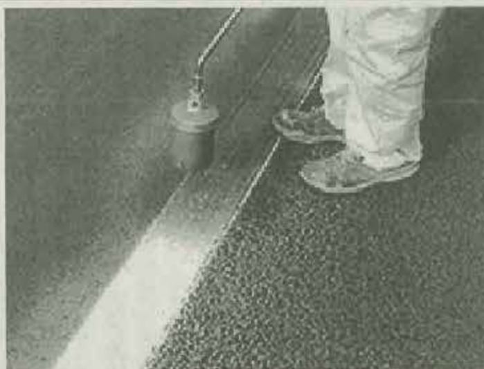
バーナー等で塗膜を加熱することで簡単に仮設ラインを消去
