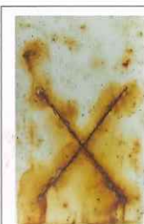
水性二液エポキシ防錆プライマー
