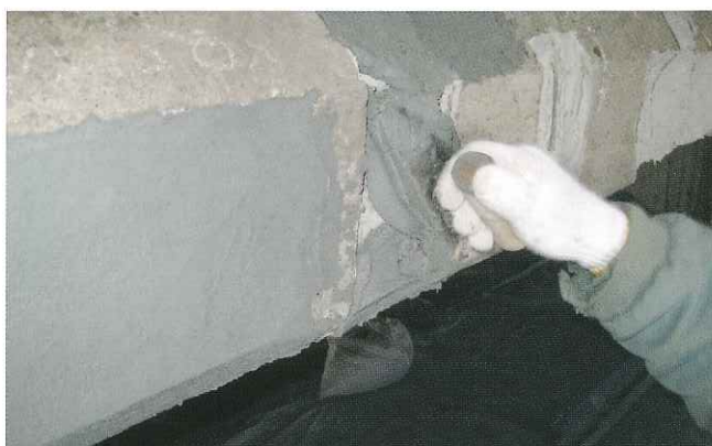
③断面修復材による充填
