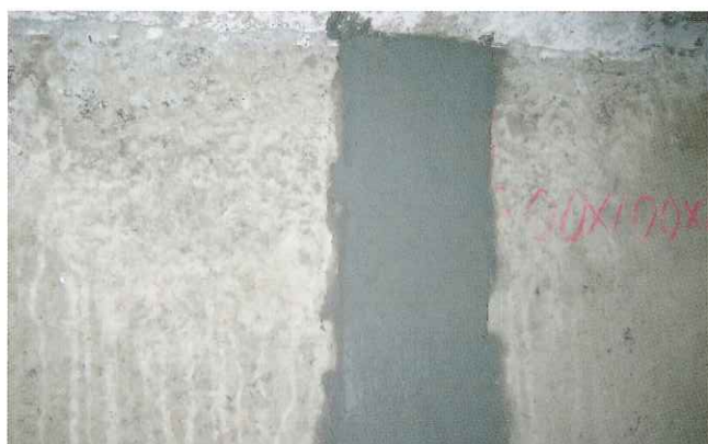
④仕上がり状態
