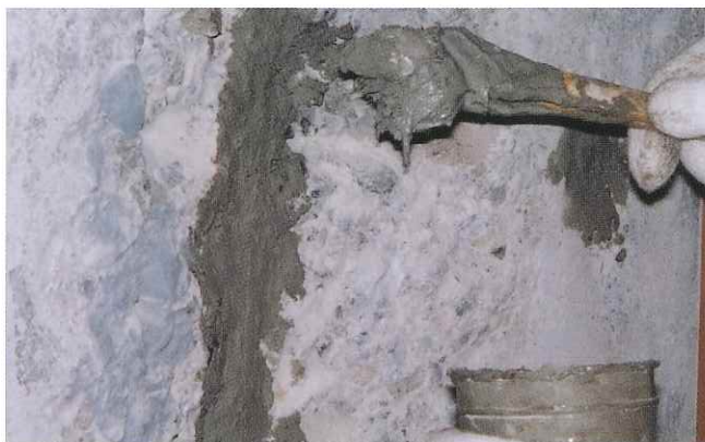
①鉄筋防錆材の塗布
