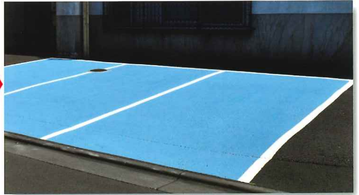
鮮やかによみがえりました！ (駐車面にフロアトップ#1000 速乾 スカイブルーを施工)
