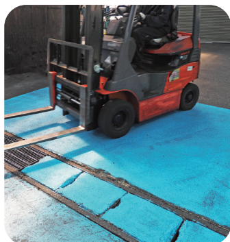
《ブロックの上も剥離なし》
