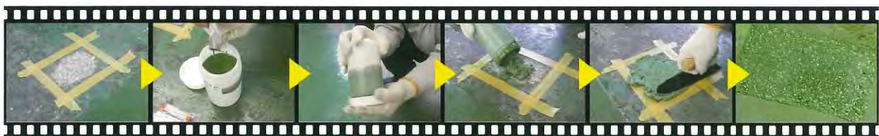
①施工する箇所を養生
