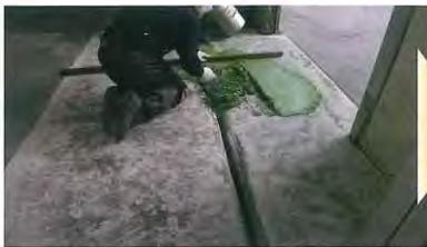
混合した材料を速やかに施工箇所にまき、隙間がないよう詰める
