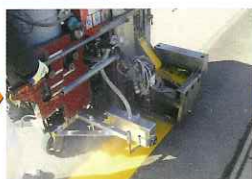
プライマー塗装後、下塗り施工
