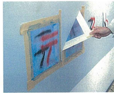
3.「セラペロン」乾燥後、布テープごと剥がして落書きを除去します。
