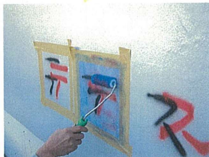
2.布テープを貼り、「セラペロン」を塗装し、乾燥させます。
