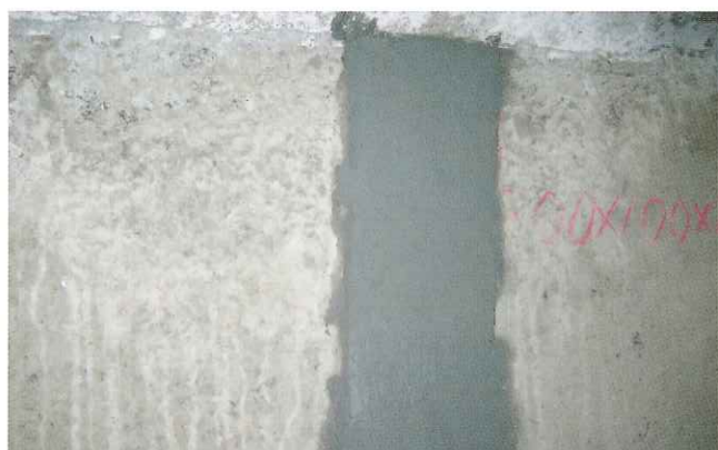
④仕上がり状態
