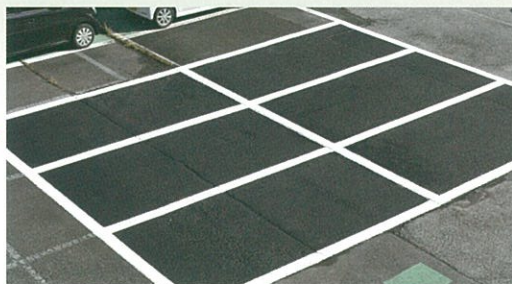
この通り！ ※ラインにはW-100、駐車面は水性パーキングブラックを施工しています。
