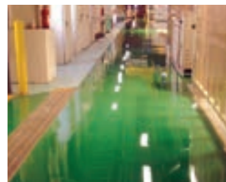
工場床の施工例
