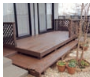
ウッドテラスの塗装例
