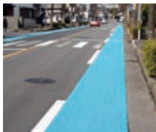
道路の歩車道分離の施工例
